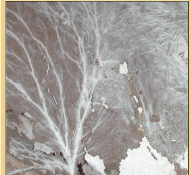
typischer Mycelbewuchs auf Gipsplatte durch den Weissen Porenschwamm, *Antrodia sp.*
